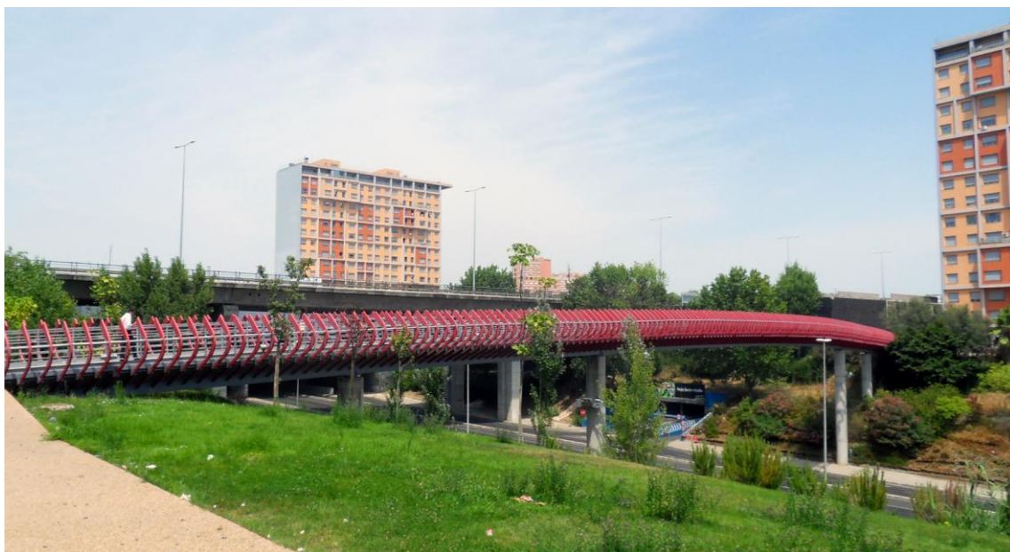
Figura 78. A passagem pedonal situada no espaço do nó da Bela Vista une as duas praças localizadas em frente às entradas no espaço comercial.
