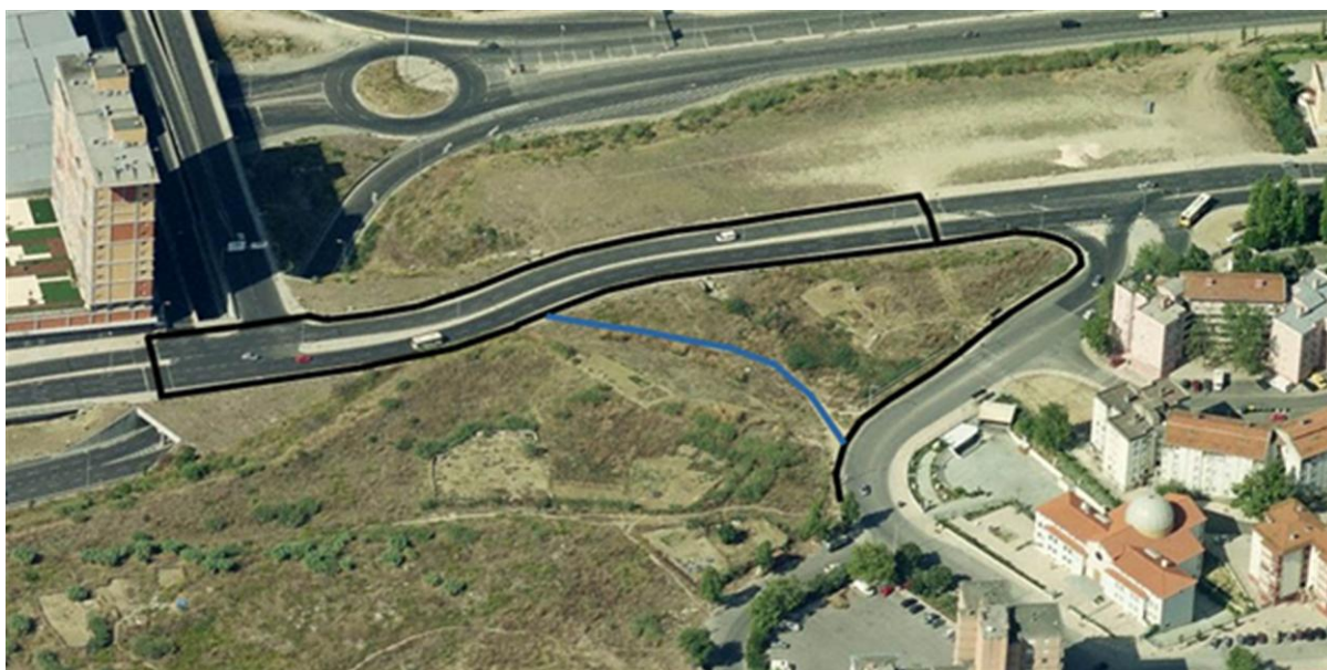
Figura 53. Percursos possíveis entre o Bairro das Amendoeiras e o nó viário da Bela Vista.
