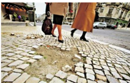
Figura 7. Um pavimento em mau estado de conservação constitui um obstáculo à mobilidade pedonal.
