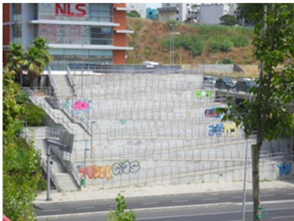
Figura 6. Exemplo do uso de escadas e de rampa no nó viário da Bela Vista, Lisboa. O percurso em rampa cumpre as regras de acessibilidade mas parece longo e penoso de se fazer.
