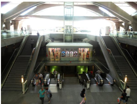
Figura 23. Comunicações verticais entre o piso térreo e o piso subterrâneo na Gare do Oriente.
