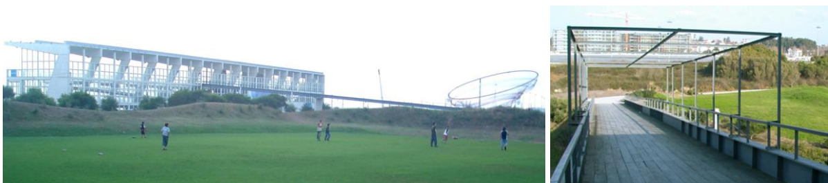
Figuras 34 e 35. Rampa pedonal de ligação entre o Parque da Cidade e o “Edifício Transparente”
